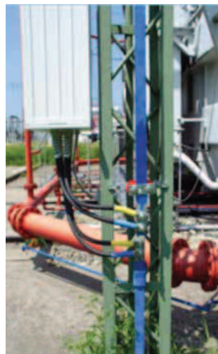
Wpięcie układu pomiarowego w punkt zerowy transformatora.
